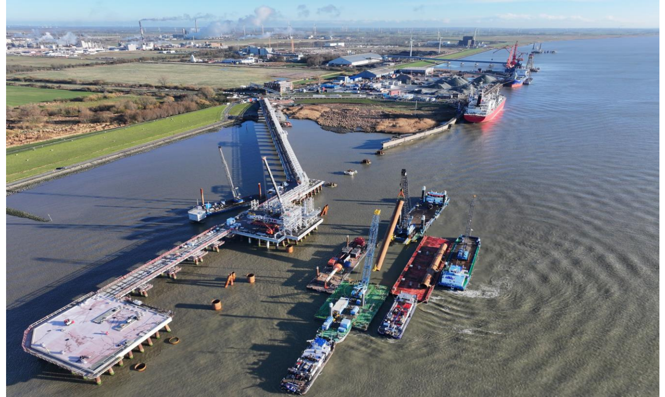
Abb.7: Im Bau befindliche Jetty am Elbehafen
