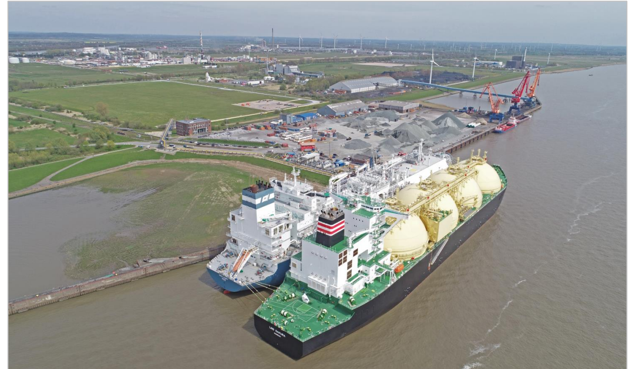
Abb.2: Schiff mit Flüssiggas am schwimmenden LNG-Terminal (FSRU) am Elbehafen
